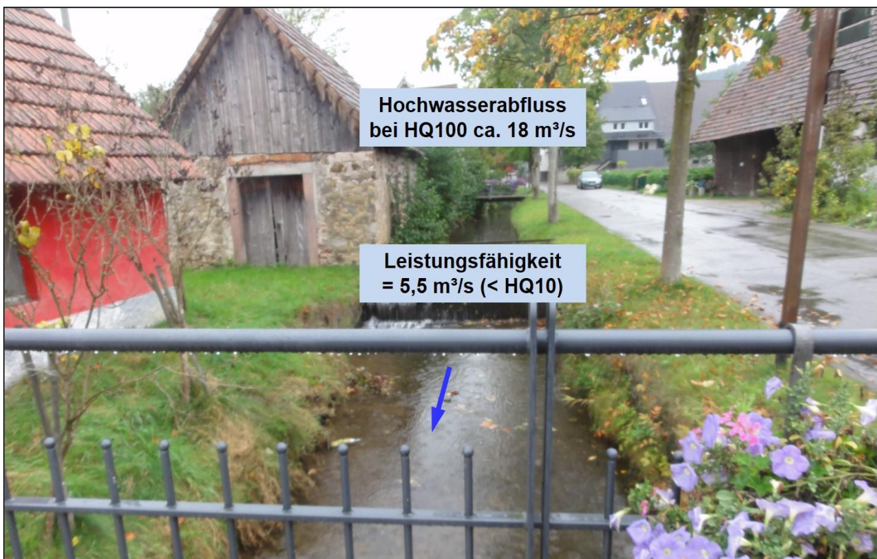
Abbildung 3.12: Leistungsfähigkeit und HW-Abfluss am Entersbacher Dorfbach
