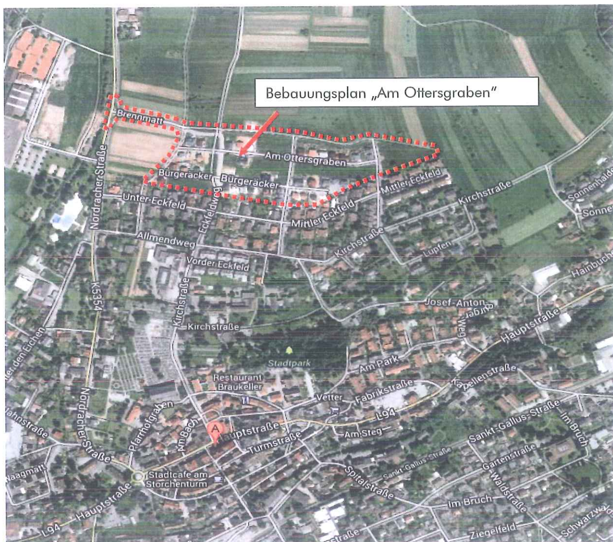
Abbildung 2: Luftbild (Quelle Google) mit Lage des Plangebiets
