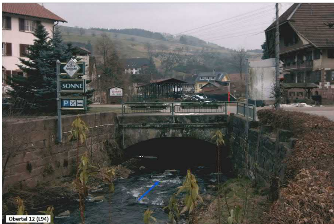
Abbildung 2.5: Bogenbrücke über den Harmersbach, Obertal 12 (L94, Teilbereich 3)
